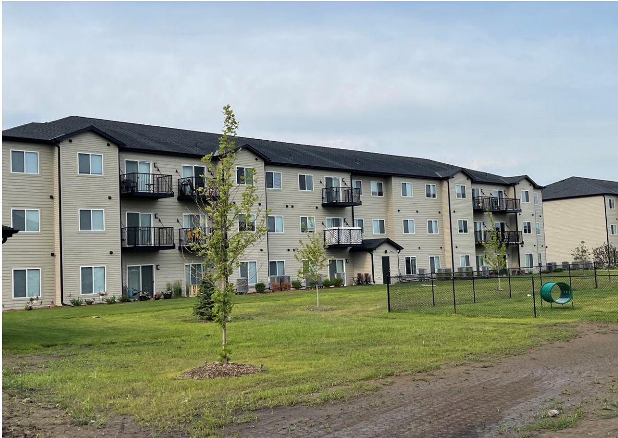
Fremont Commons apartments
